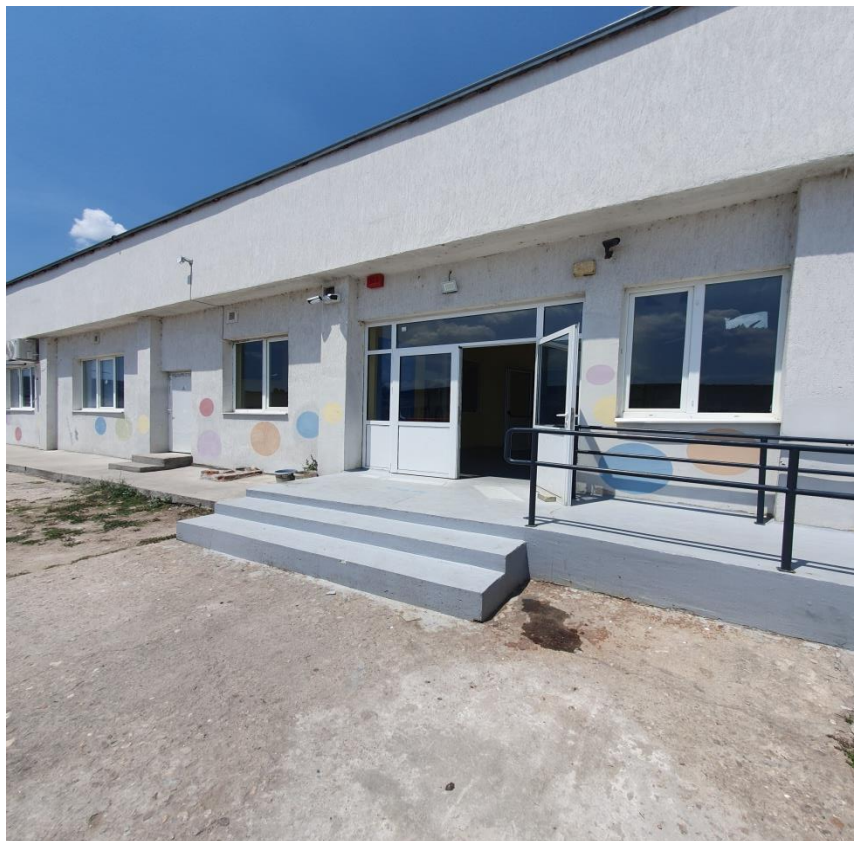
Вход на сигурната зона, изградена в 10-то хале
